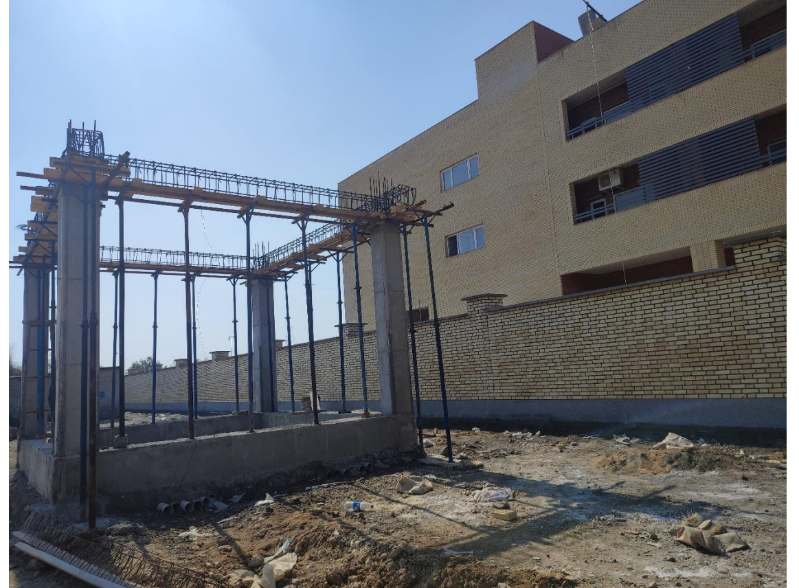
احداث پست برق
